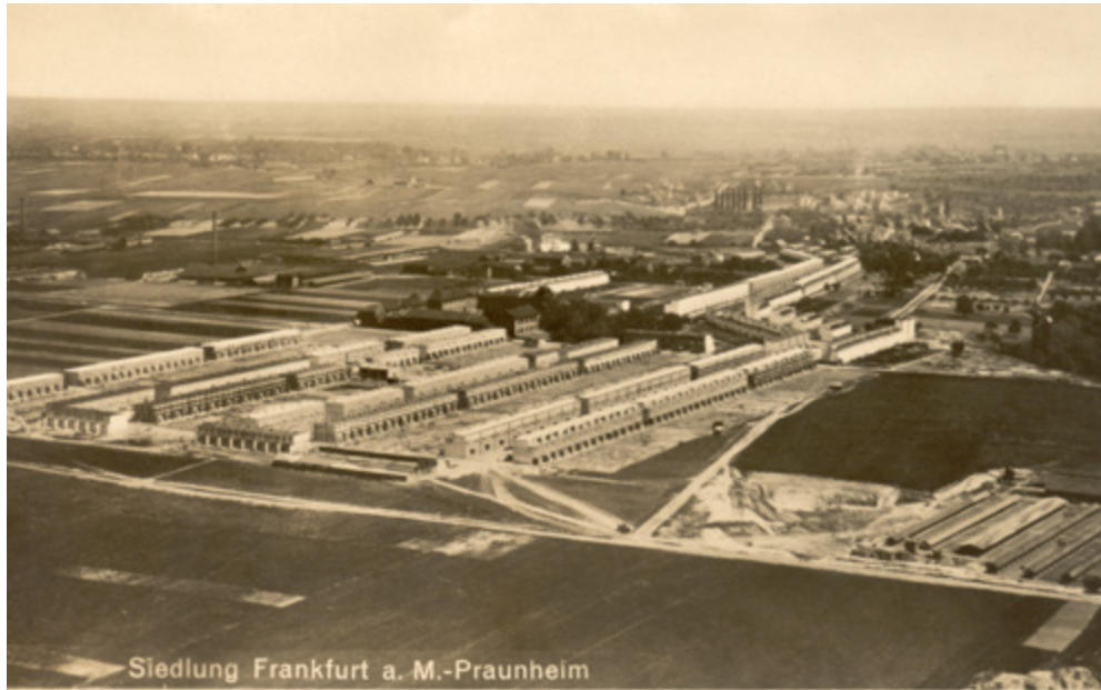
Der im Bau befindliche Bauabschnitt II westlich des Hofgutes.
