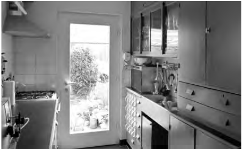
Abb. 2 Frankfurter Küche, Siedlung Praunheim, Einfamilienwohnhaus Typ V P. In diesem Grundrisstyp misst die Frankfurter Küche 4,3 qm, in die man vom Wohnraum (25 qm) über einen Essraum (7 qm) gelangt. Hier hat ein enthusiastisches Paar die gut erhaltenen Schränke der 20er Jahre aufgearbeitet und die Wand zum Essraum geöffnet. Gespült wird mit der Hand. – Vielen Bewohnern der May-Siedlungen ist deren Entstehungsgeschichte bewusst. Einige wohnen dort noch in der ersten Generation.
